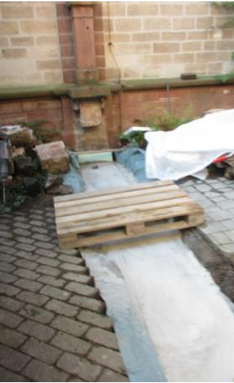
Fundament, mit Folie abgedeckt
