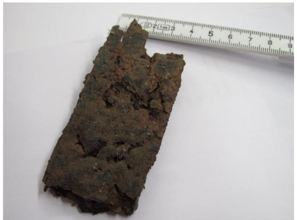
Futterblech der Verankerung, vollständig korrodiert
