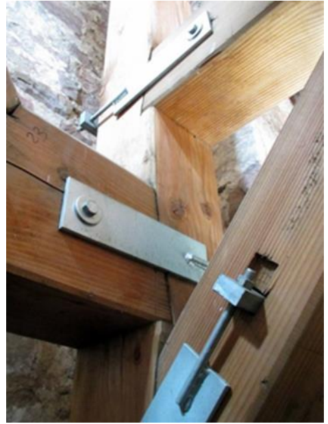
Typischer Knotenpunkt mit Nachspannmöglichkeiten
